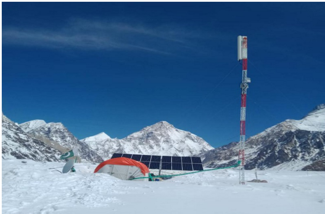
中兴通讯-巴基斯坦世界第二高峰乔戈里峰登山大本营通信网建设项目 ZTE-Constructing base station at K2 base camp in Pakistan
