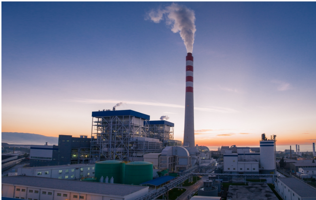
土耳其 atlas 电站项目—电站全景图 Панорама электростанции Алтас (Турция)
