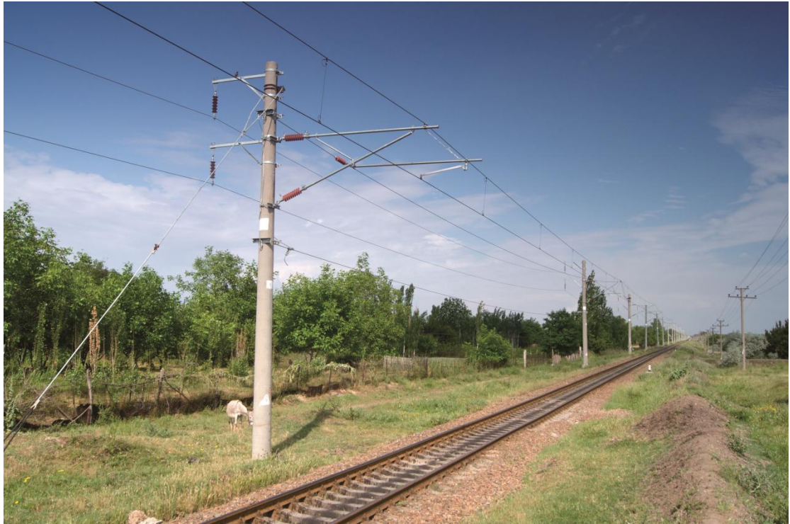
中铁电气化局集团有限公司-乌兹别克斯坦土库马奇-安格连铁路电气化项目接触网工程 Контактная сети по проекту электрификации железнодорожного участка Тукимачи-Ангрен в Узбекистане
